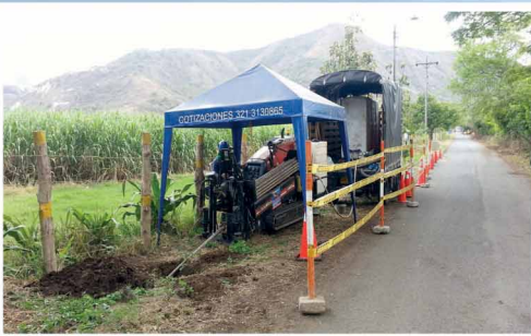
PERFORACIONES HORIZONTALES DIRIGIDAS
