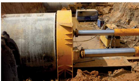
HINCADO DE TUBERIA POR METODO PIPE RAMMING
