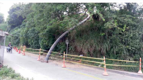
RESTITUCIÓN DE TUBERÍAS POR EL METODO PIPE BURSTING
