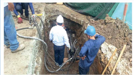
PERFORACIÓN NEUMÁTICA CON TOPO
